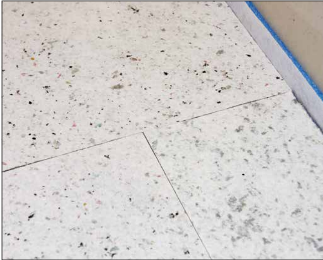
13 Plattenstöße nebeneinanderliegender Reihen werden versetzt verlegt.
