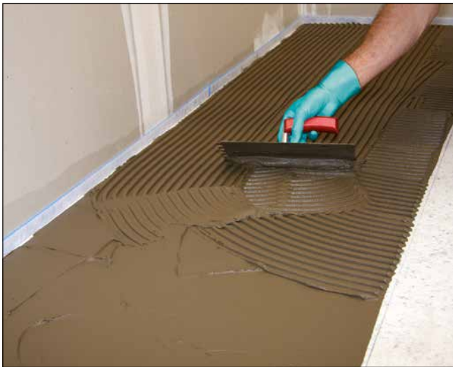
15 Auftrag von z. B. Sopro's No. 1 Flexkleber mit einer Zahnkelle auf die Sopro FliesenDämmplatte für die anschließende Verlegung des keramischen Belages.
