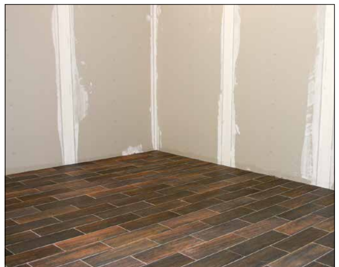
18 Entkoppelter, frisch verlegter und verfugter keramischer Belag auf einem Holzuntergrund.
