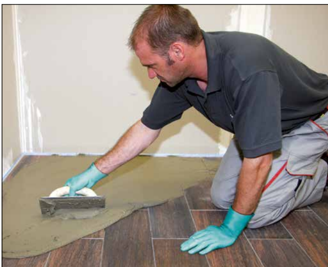
17 Verfugen der Fläche mit z. B. Sopro DF 10® DesignFuge Flex
