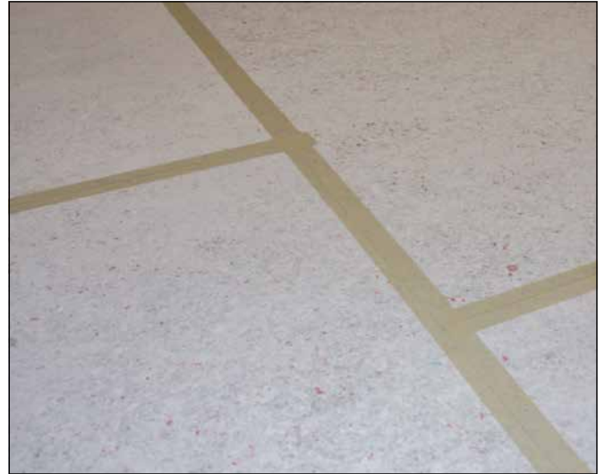
14 Zur Vermeidung von Mörtelbrücken (Körperschallbrücken) werden die Stöße der Platten mit Klebeband überklebt.
