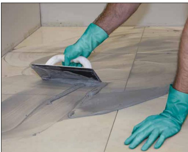
5 Verfugung der Fläche nach Begehbarkeit mit einer Sopro Fugenmasse (z. B. Sopro DF 10® DesignFuge Flex).
