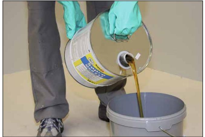
2 Speziell bei Großformatverlegungen ist die Fläche mit Sopro MultiGrund zu grundieren, um eine Rückdurchfeuchtung zu verhindern. Der einkomponentige Sopro MultiGrund ist zur einfachen Verarbeitung in einen sauberen und trockenen Eimer umzufüllen.
