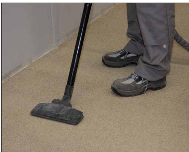
5 Überschüssiger Quarzsand wird nach vollständiger Trocknung des Sopro MultiGrunds (nach 30–40 Minuten) mit einem Industriestaubsauger oder einem Besen aufgenommen.
