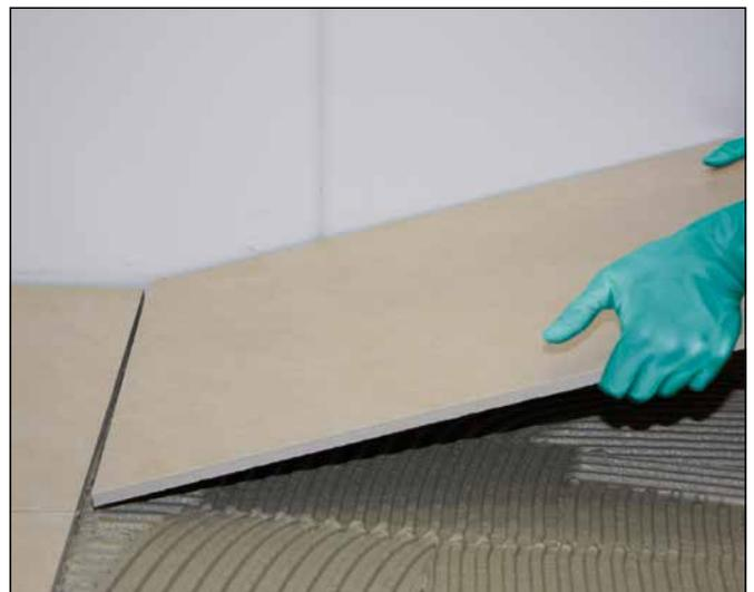
4 Großformatiges Feinsteinzeug in das Kammbett einlegen und ausrichten.
