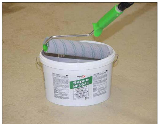
6 Alternativ zur Absandung kann nach dem Abtrocknen der ersten Lage des Sopro MultiGrunds ein Anstrich mit Sopro HaftPrimer S erfolgen. Trocknungszeit Sopro HaftPrimer S: 1–2 Stunden.
