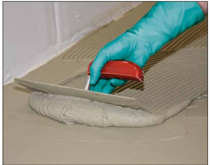
2 Aufziehen des Sopro VarioFlex® XL in der Dünnbettkonsistenz auf die vorbereitete Kontaktschicht.
