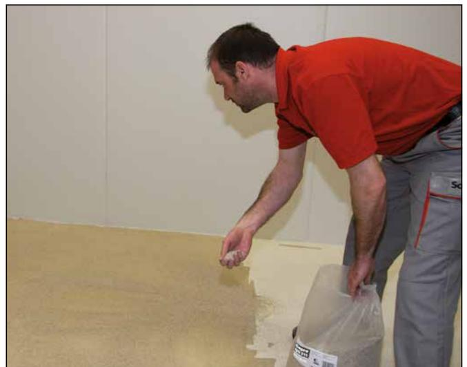
4 ... und direkt mit Sopro Quarzsand grob (0,4–0,8 mm) abgestreut werden.
