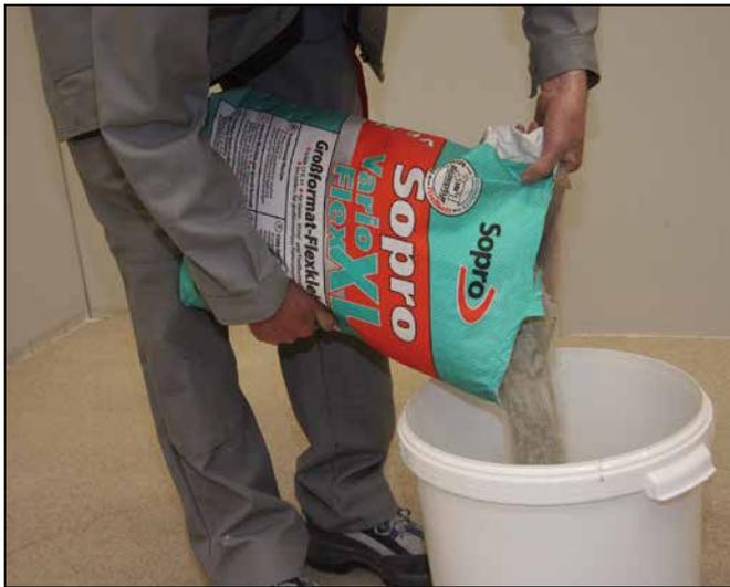
1 Entleeren des staubreduzierten Großformat-Flexklebers Sopro VarioFlex® XL in den Anmischeimer.
