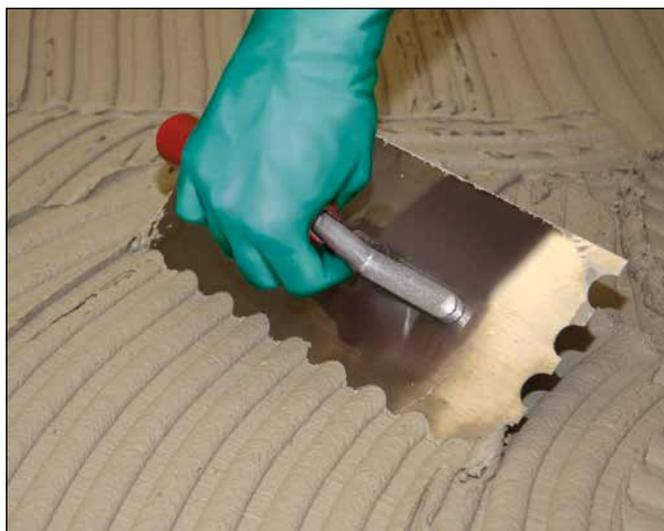
1 Aufziehen des Sopro VarioFlex® XL in der Mittelbettkonsistenz auf die vorbereitete Kontaktschicht.
