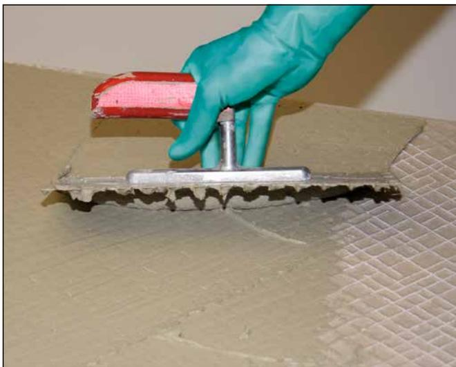
**3** Aufziehen einer Kontaktschicht auf die Rückseite der großformatigen Feinsteinzeug-Fliese (Kombiniertes Verfahren).
