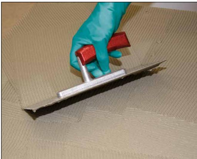
3 Bei großformatigen Platten ist das „Kombinierte Verfahren“ anzuwenden. Aufbringen einer Kontaktschicht aus Sopro VarioFlex® XL auf die Rückseite der Platte.
