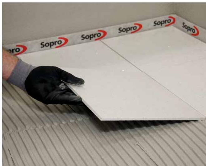
2 Einlegen einer Aggloplatte. Aufgrund der Schnellerhärtung eignet sich Sopro FKM® Silver auch für die Verlegung verformungsempfindlicher Beläge.
