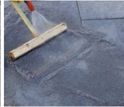
Mörtel mit Hartgummischieber und Wassersprühstrahl einarbeiten und sauber abspülen
