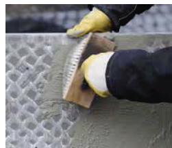
Plattenunterseite mit Kontaktschlämme versehen und „frisch in frisch“ verlegen
