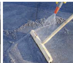
Fugenmörtel einfügen
