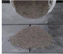
Mörtel portionsweise aufbringen
