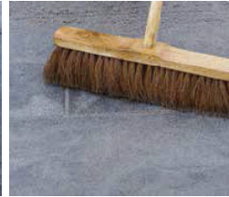
Letzte Mörtelreste ggf. mit Kokosbesen entfernen
