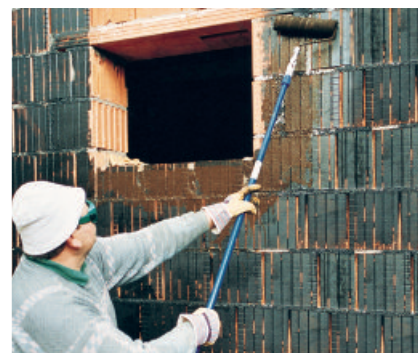
PCI Pecimor F, 1 : 5 mit Wasser verdünnt, als Grundierung für eine Bauwerksabdichtung mit kunststoffmodifizierter Bitumendickbeschichtung nach DIN 18 533.
