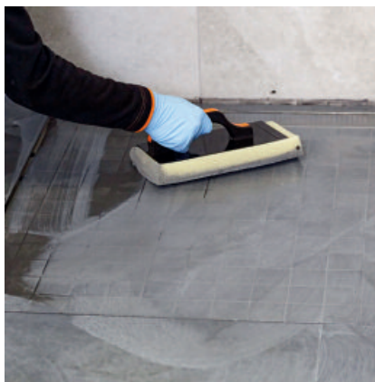
Nach ca. 10 - 45 Min. die eingefugte Fläche mit einem Schwambrett anemulgieren und sauber abwaschen.
