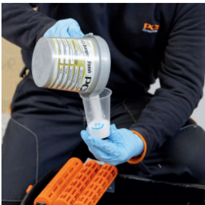
Alternativ kann auch PCI Durapox Finish (Konzentrat) MV 1:100; 5l Wasser; 50 g Durapox Finish; direkt in das Waschwasser hinzugegeben werden.
