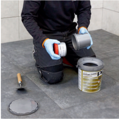
PCI Durapox Premium (Multicolor) (2 kg) öffnen und die zweite Komponente herausnehmen.
