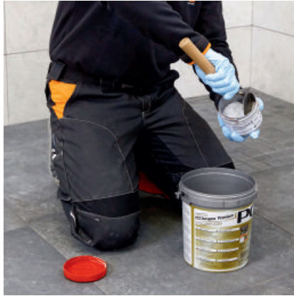
Die Härterkomponente in die Basiskomponente geben.
