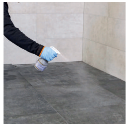
Vor dem finalen Waschgang wird nach ca. 60 Min. PCI Durapox Finish (flüssig) auf die Fläche aufgesprüht.
