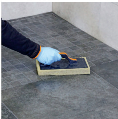
Anschließend mit dem Schwambrett den Restschleier aufnehmen und die Fläche sauber waschen.
