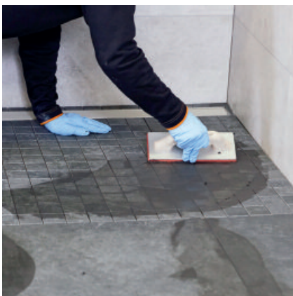
PCI Durapox Premium (Multicolor) mit einer Hartgummifugscheibe in die Fugen einbringen.
