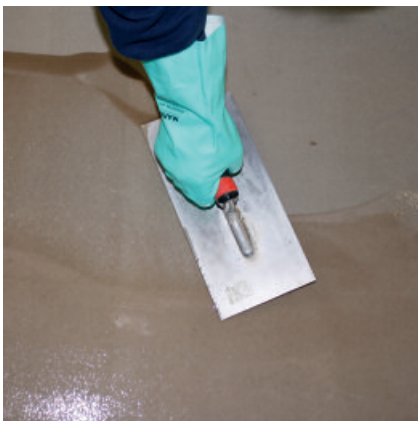
Nur eine geschlossene, porenfreie Kratzspachtelung mit PCI PUR-Grund und einer Quarzsandmischung gewährleistet eine sichere Haftung und blasenfreie Aushärtung von PCI Pursol 1K.
