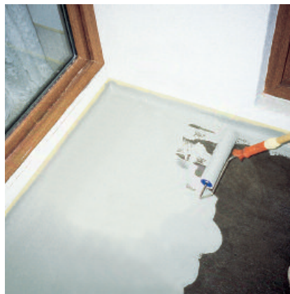
Das rissüberbrückende PCI Pursol 1K ist gebrauchsfertig und leicht mit einer kurzflorigen Rolle zu verarbeiten.
