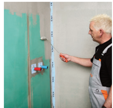
Nachdem die Details ausgebildet wurden, erfolgt die Flächenabdichtung mit dem jeweiligen Abdichtungsmaterial.
