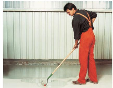
PCI Supracolor ist eine hochwertige Versiegelung – nach der Aushärtung ist sie widerstandsfähig gegen mittlere rollende und schleifende Beanspruchung.
