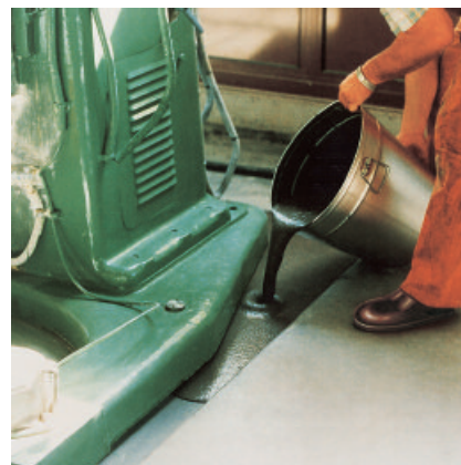
PCI Repaflow ist fließfähig und füllt horizontale Hohlräume selbstverlaufend.
