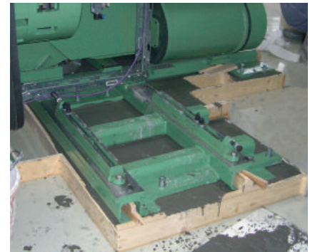
Mit PCI Repaflow werden Last abtragende Verbindungen geschaffen.
