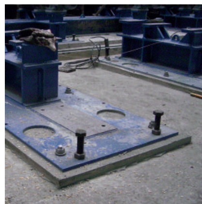
PCI Repaflow schafft eine nahtlose, risse- und hohlraumfreie Verbindung, die einen ruhigen Maschinenverlauf und dadurch präziseres Arbeiten und geringeren Maschinenverschleiß bewirkt.
