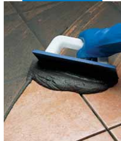
Einbringen von Keracolor FF Flexfuge mit dem MAPEI-Fugbrett
