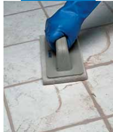
Reinigung des Belages
