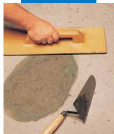
Partielle Reparatur: Abglätten der frischen Flickstellen
