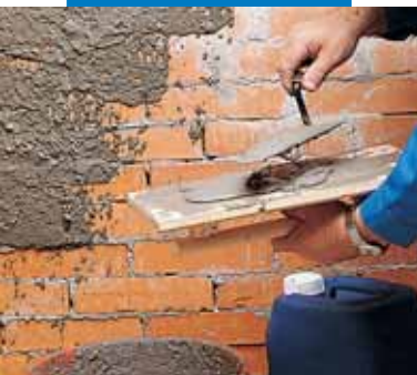
Auftragen eines mit Planicrete modifizierten Spritzbewurfs
