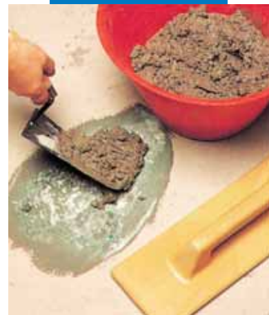
Partielle Reparatur: Auftragen des Mörtels
