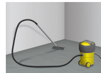
1 Reinigen des tragfähigen Bodenuntergrundes
