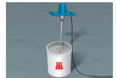
4 Anmischen des Klebemörtels
