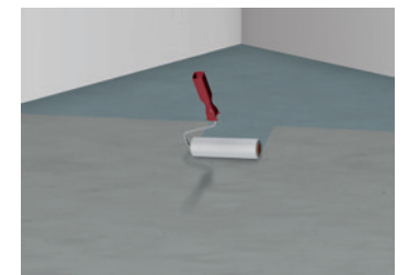
2 Grundierung des Untergrundes, z.B. mit ASO®-Unigrund
