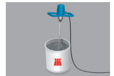
6 Anmischen der Ausgleichsmasse
