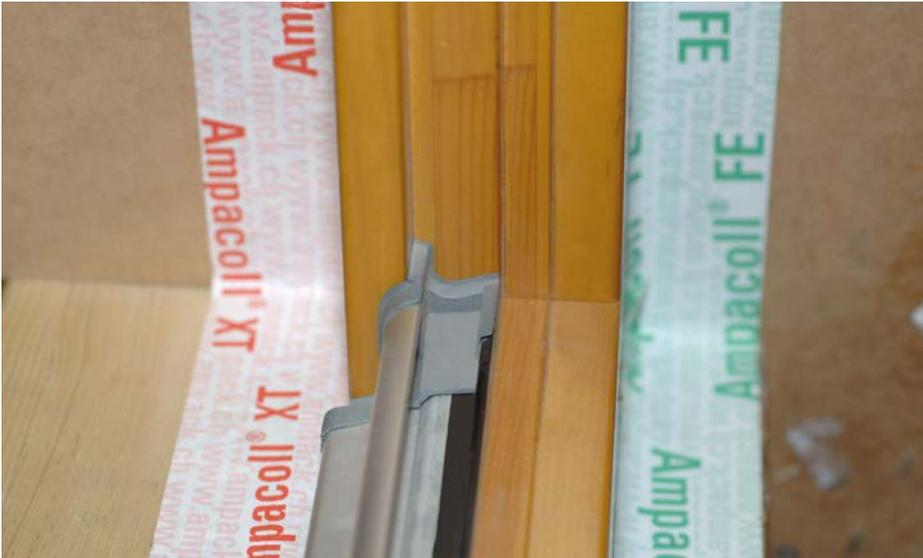
Fenstereinbau – 12 mm für Anschluss Klebeband auf den Fensterrahmen, Rest (48 mm) dann auf die Leibung
