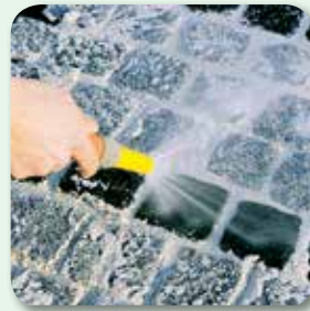
mit Wassersprühstrahl und feuchtem Besen abreinigen
