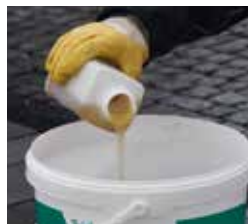
Bindemittelkomponente zugeben und homogen aufrühren
