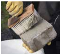
Belagsunterseite mit Kontaktschlämme einstreichen
