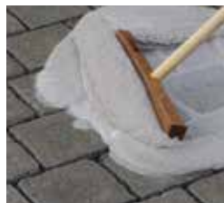
Eimerinhalt mit Gummischieber einbringen
