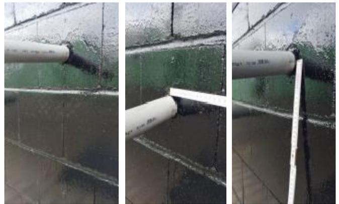
2. Den Rohrdurchmesser ausmessen und auf dem Vlies der anzubringenden Noppenbahn aufzeichnen. Den Rohrdurchbruch entweder wie ein „X“ diagonal einschneiden, oder als einen runden Kreis (minimal kleiner als der Rohrdurchmesser) ausschneiden. Dann horizontal zum (kürzeren) seitlichen Ende die Noppenbahn einschneiden.
