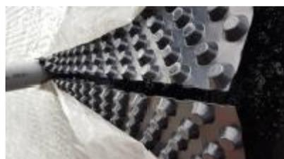
5. Aus einem Reststück von der Noppenbahn einen Streifen schneiden (so lang wie der Einschnitt aus Punkt 3 und 4) mit einer Breite von ca. 15 cm. Das Vlies von diesem Streifen komplett lösen. Nachfolgend direkt an der oberen sowie an der unteren Kante beidseitig haftendes Butylklebeband anbringen.
