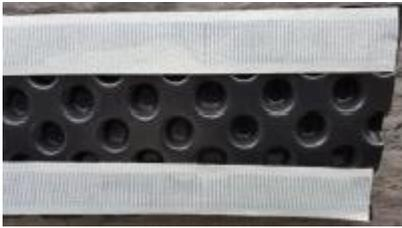
6. Den Schutz des Butylklebebandes abziehen und den Streifen wie abgebildet – Noppe in Noppe drückend – auf die vom Vlies freigelegte Noppenbahn an der Schnittstelle sowohl oben als auch unten andrücken. Anschließend auf Höhe des Schnittes einen weiteren Streifen Butylklebeband anbringen.
