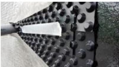
7. Den Schutz des Butylklebebandes abziehen und das Vlies auf dem Butylstreifen wieder andrücken. Somit deckt das ursprüngliche Vlies den Noppenbahnstreifen, welcher nachträglich aufgesetzt wurde, mit ab.
